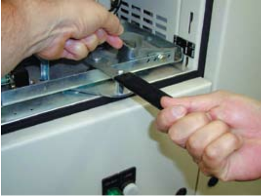
Blokset Mw 型抽屉插入 Blokset type Mw Drawer insertion
